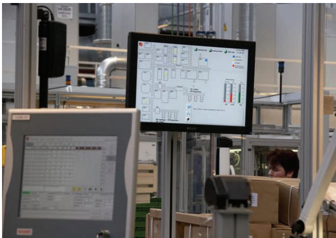
På storskærme kan alle maskiner og ordrestatus følges
